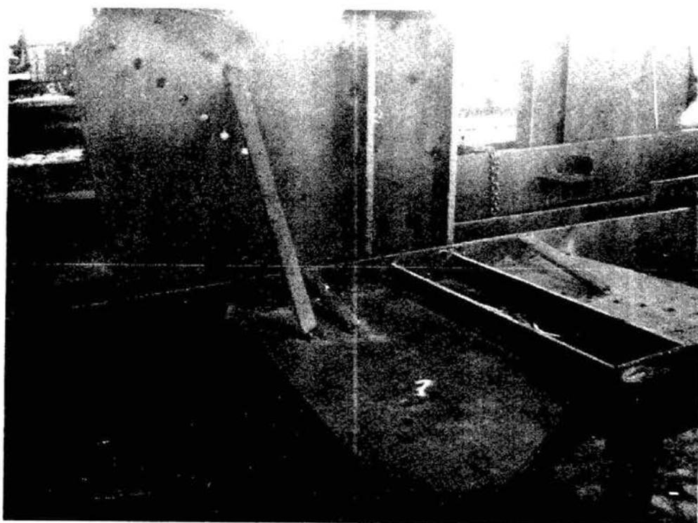
شکل ۶-۴۰ استفاده از میله به عنوان مهار جهت جلوگیری از اعوجاج زاویه‌ای در جوش ورق بادبند.
