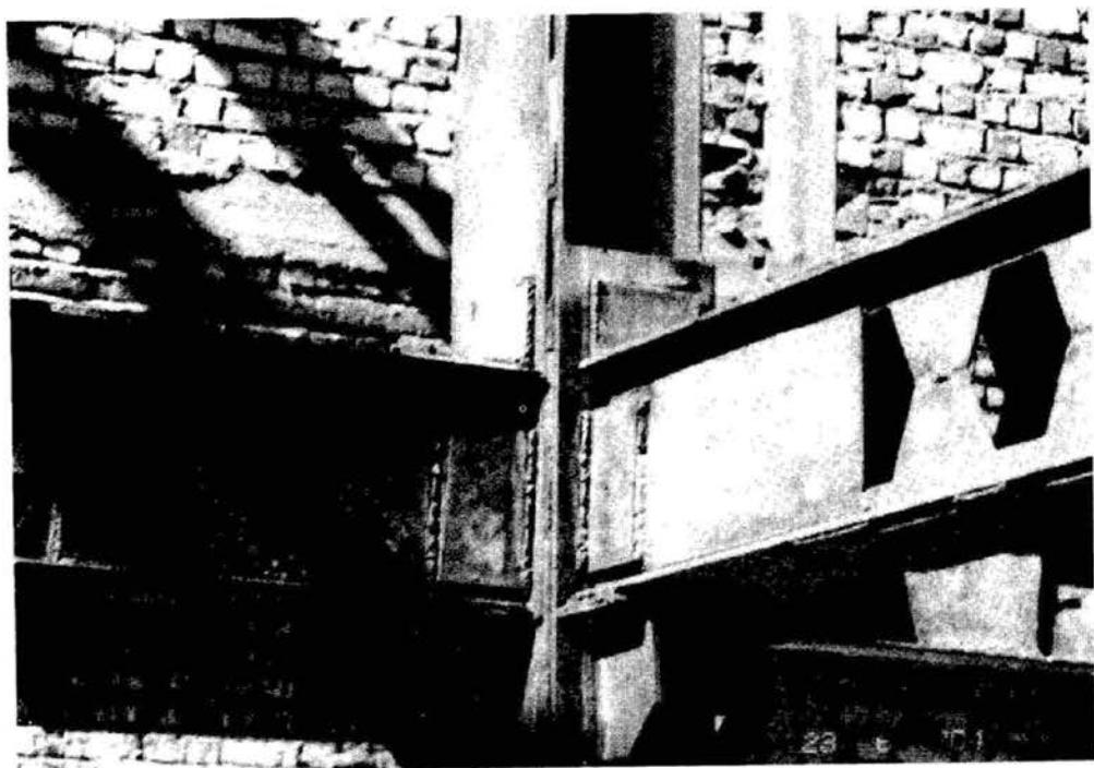
شکل ۷-۹ نمونه جوش‌های پذیرفته شده در بازرسی عینی.
