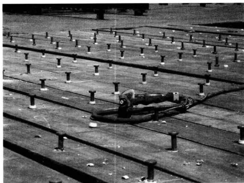
شکل ۱ - ۱۶ - جوشکاری گل میخ بدروش قوسی با انبر تپانچه‌ای شکل در کارگاه.
