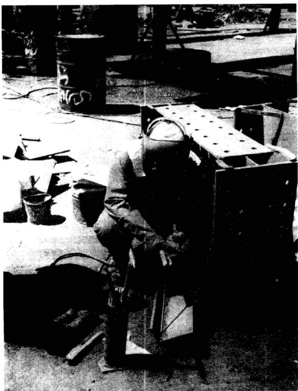
شکل ۸ - ۶ انجام جوش گوشه از مایشی در وضعیت نخت (VF)
