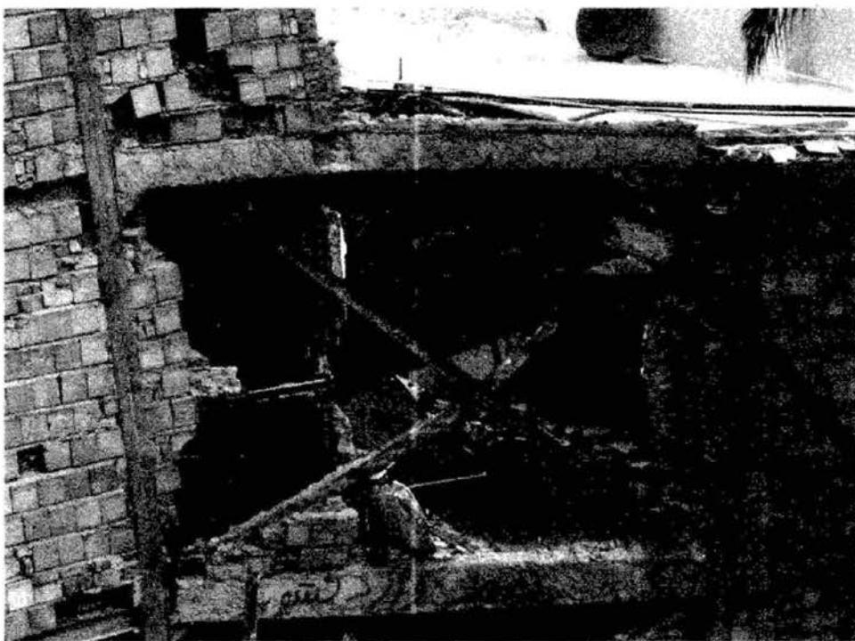
شکل ۱۳-۱۴ جوش ناقص ورق اتصال بهستون که سبب کنده شدن ورق تحت نیروی جانبی زلزله شده است (زلزله به).
