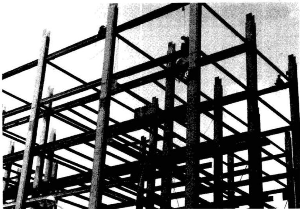
شکل ۹-۶۵ شاقولی کردن ستون‌ها و هم‌محور کردن تیرها.
